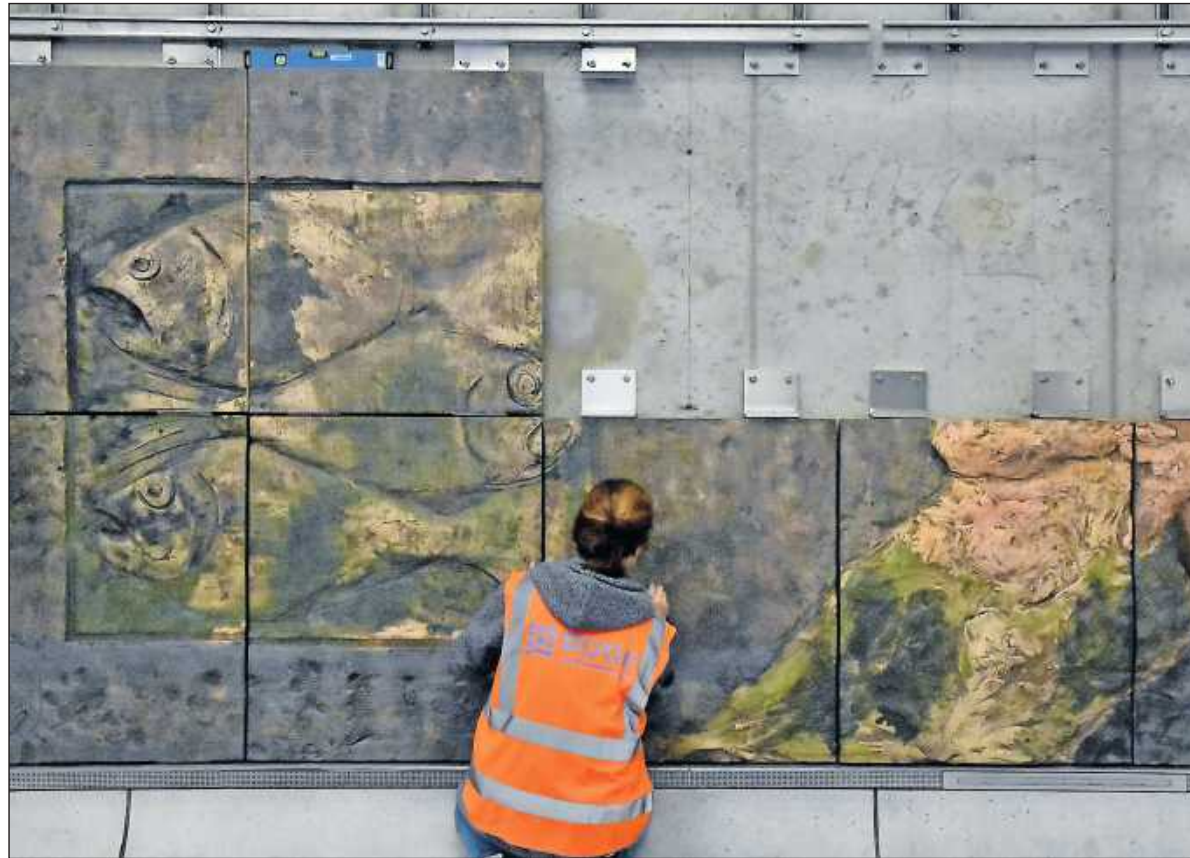
Die letzten Platten des 14-teiligen Keramik-Reliefs in Karlsruhes U-Bahn werden montiert.
